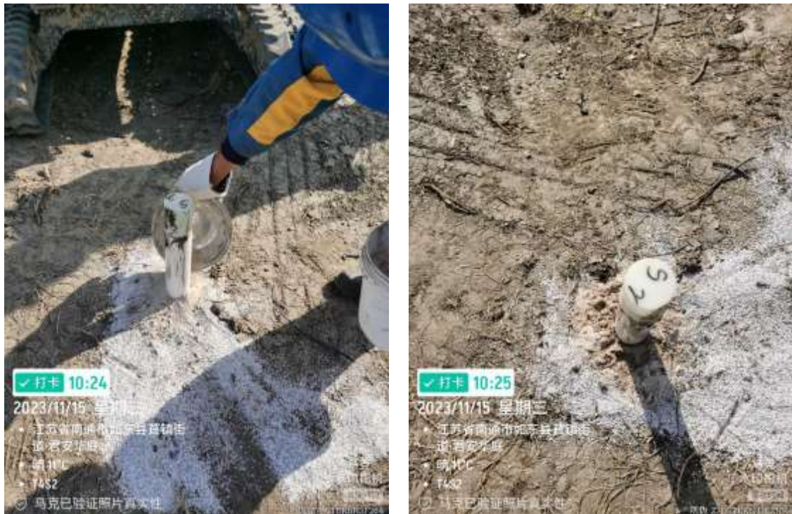
图 5-8 现场采样井建设
